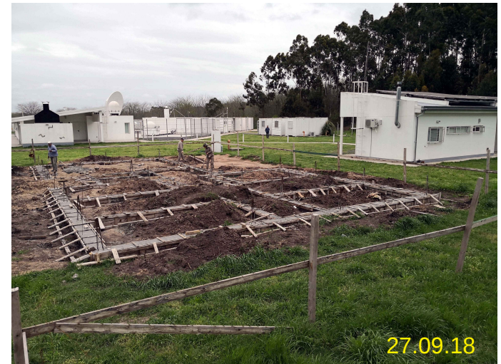
construcción de las oficinas
