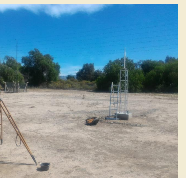
Instalación de la Antena DORIS
