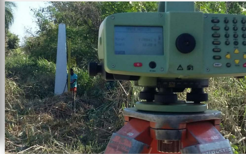
Nivelamento no marco de fronteira
