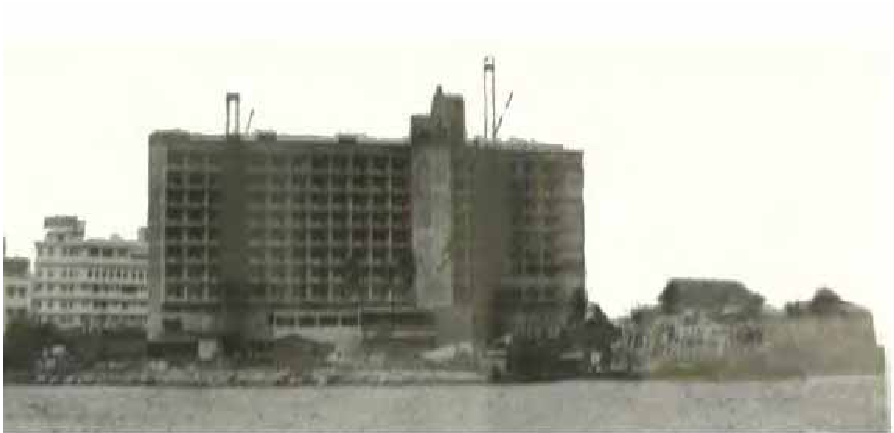
Fecha de 1948 durante la construcción del Hotel se distingue el Fortín
