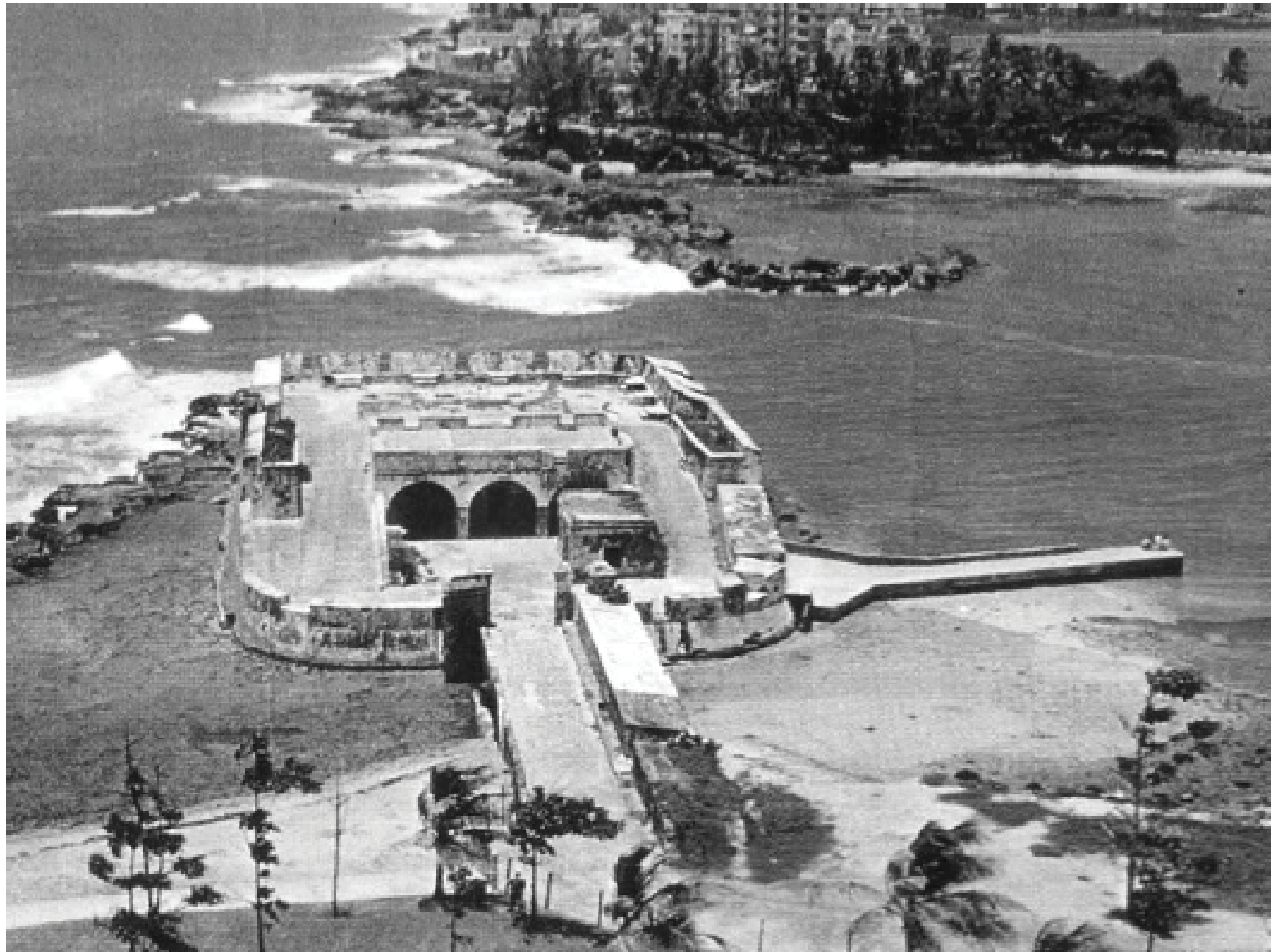
Fecha 1950, no se tiene columnas en la entrada del puente del Fortín
